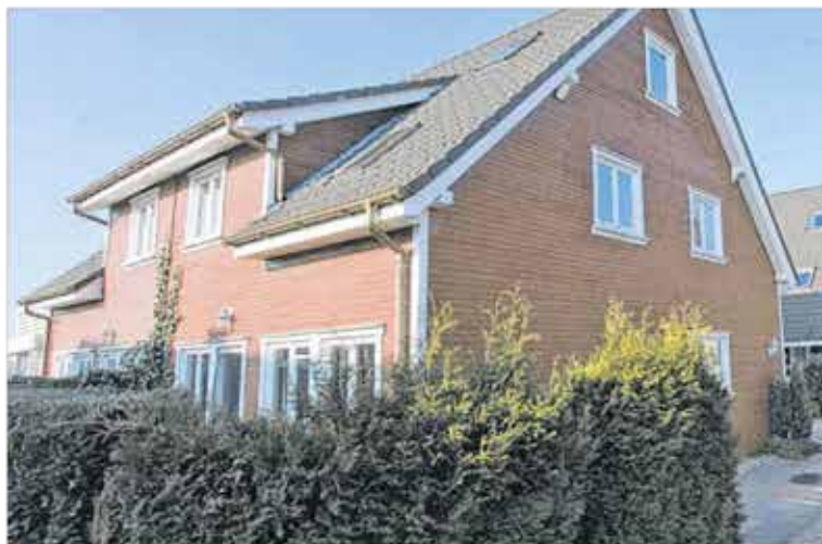
Am 9. Februar flog ein Brandsatz durch ein Fenster ins Innere dieser Flüchtlingsunterkunft.
